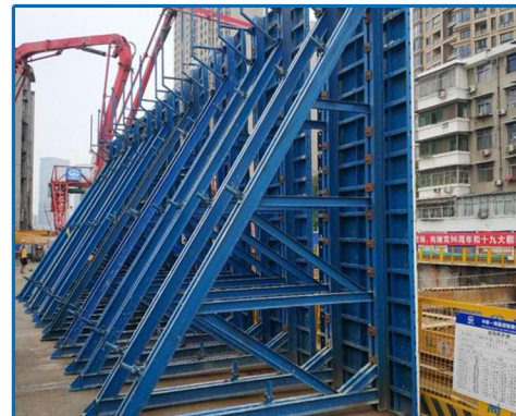
▶ 地铁单侧墙模板
